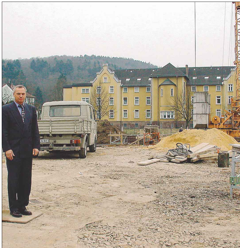
Bad Salzschlirfs Bürgermeister Ernst August Stender (56) an der Baustelle des neuen Feuerwehrgerätehauses. In einer Sitzung der Gemeindevertretung wird der Verwaltungschef der Kurgemeinde nach zwölf Bürgermeisterjahren am Donnerstagabend verabschiedet. Foto: Sigrid Stock
